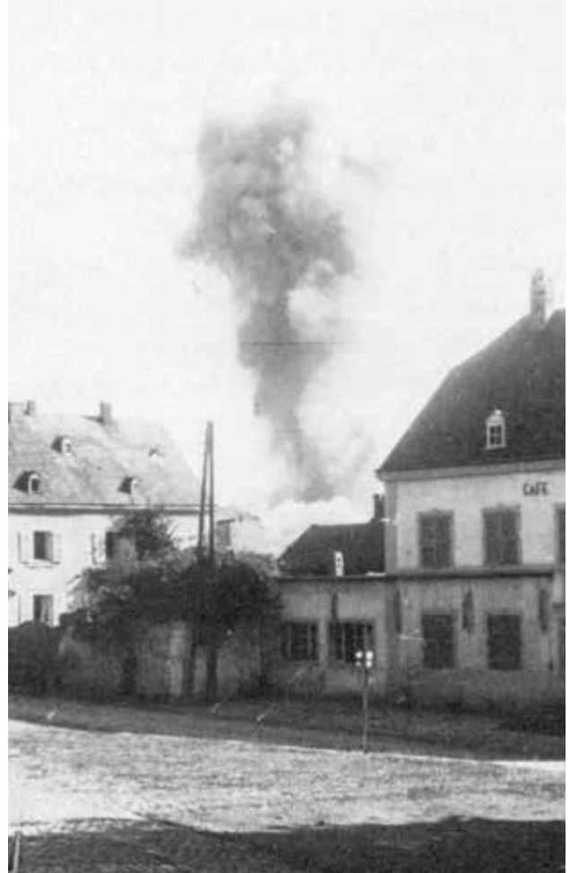
Sprengung der Laangbréck .
